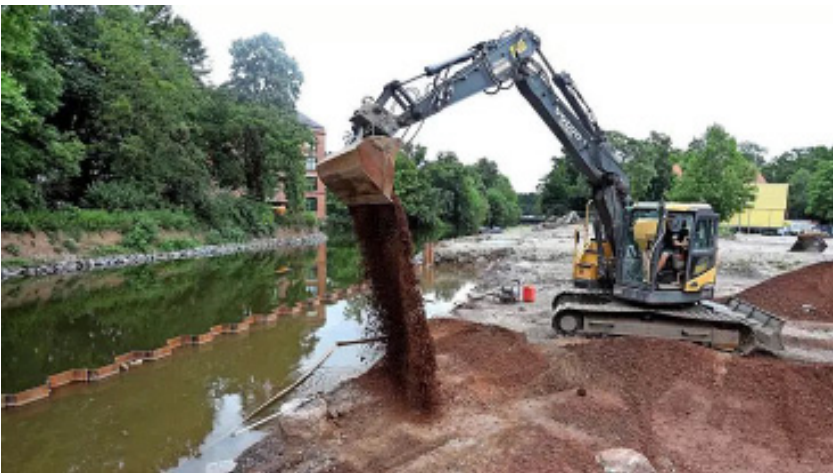
Die Bagger sind auf der Baustelle für den Erweiterungsbau des Kanubootshauses am Klingerweg in Aktion. Dabei entsteht eine Ufertasche neben der Weißen Elster. Foto: André Kempner
