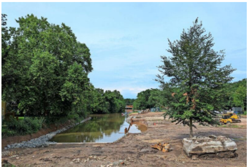
Die Arbeiten an der sogenannten Ufertasche - einer Gewässer-Ruhezone - werden gegenwärtig abgeschlossen. Foto: Dirk Knofe
